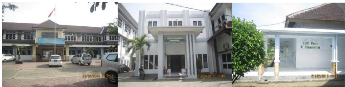
Gambar 2.2 kondisi bangunan RSUD dr. Soedomo Kabupaten Trenggalek
